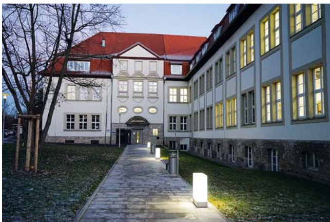
► Abb. 7 Eingangsbereich der Hautklinik nach abgeschlossener Sanierung 2016 (Foto: M. Goebeler).
