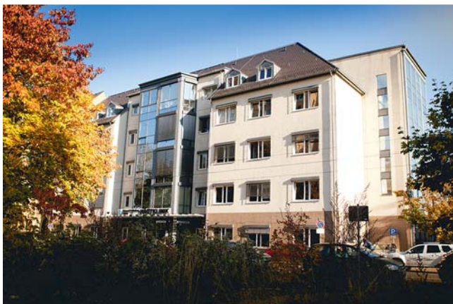
► Abb. 3 Eingangsseite der 2006 fertiggestellten neuen Hautklinik in der Philipp-Rosenthal-Straße (Foto M. Karsten/UKL).
