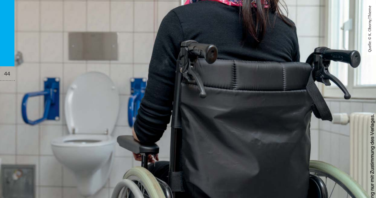
Sanitäranlagen mit Griffen und ausreichendem Platz für Rollstühle gehören zum A und O der Barrierefreiheit.
