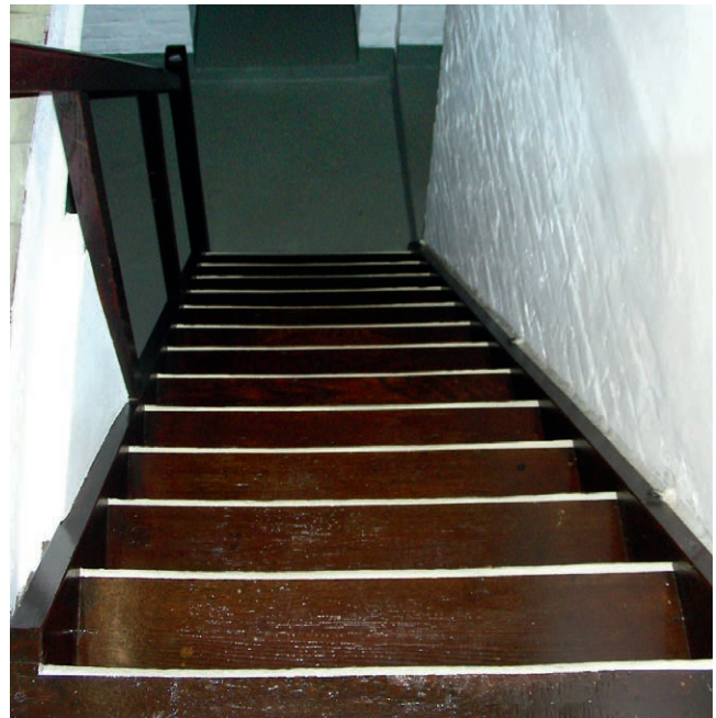
Abb. 2 Abgang in den Waschraum eines Mehrfamilienhauses. Mit einem zweiten Handlauf wäre der Durchgang zu schmal. Die Gemeinschaft kann hier die Stufen kenntlich machen und für eine gute Beleuchtung sorgen.
