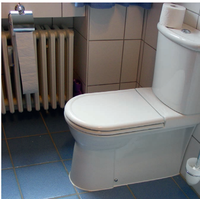
Abb. 3 In diesem Badezimmer wurde eine erhöhte Toilette eingebaut und die Papierrolle leicht erreichbar angebracht.
