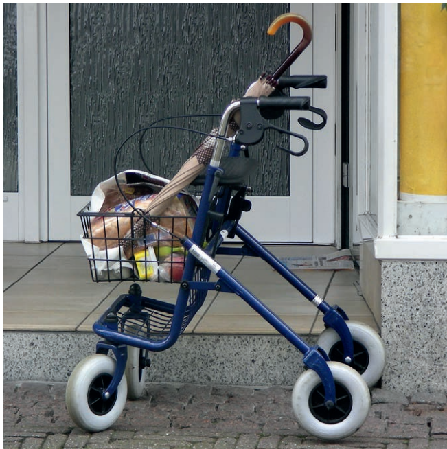
Abb. 1 Eine Barriere im Außenbereich: Bei einer solchen Stufe kann die Nutzerin des Rollators an ihre Grenzen kommen. Hier wäre eine Rampe sinnvoll.
