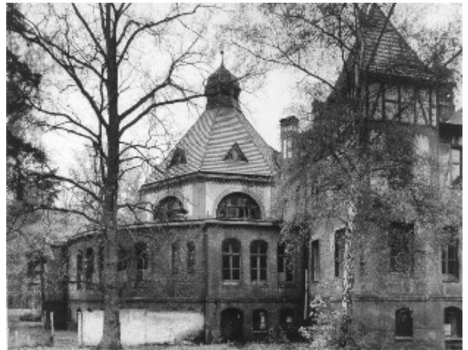
Abb. 7 Die Zentralbadeanstalt (aktueller Zustand).
